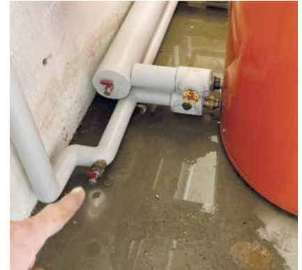
— Korrosionsschäden
